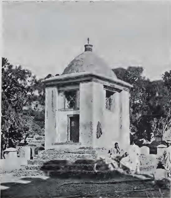
Abb. 221. Nördliches Glockenhaus vor der Zionskirche.
